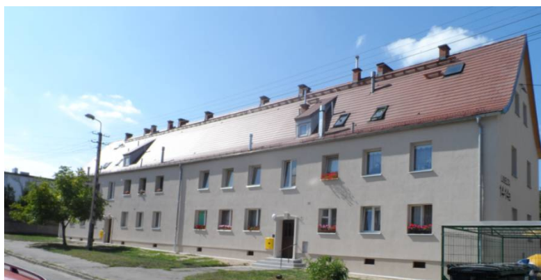
Fot. 2. Widok elewacji frontowej budynku przy ul. Libelta 14, 14A po remoncie.
