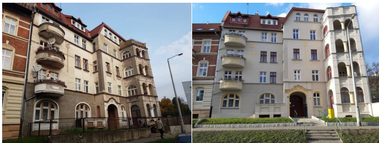
Fot. 1 i fot. 2. Widok elewacji frontowej budynku przy ul. Nadgórnej 57 – stan przed i po remoncie.
