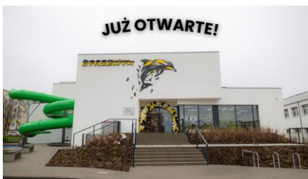
Fot. Geotermia Grudziądz Sp. z o.o.
